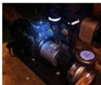
8 bombas estacionarias y una sumergible, con una capacidad instalada de 350 Kw Para una altura de 460 m
