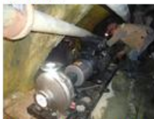
8 bombas estacionarias y una sumergible, con una capacidad instalada de 350 Kw Para una altura de 460 m
